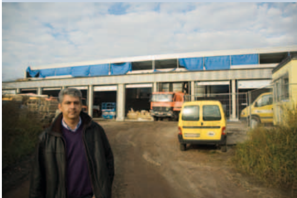
Schepen voor openbare werken Geert Van Der Auwera volgt de vooruitgang van de werken aan het GTC op de voet
